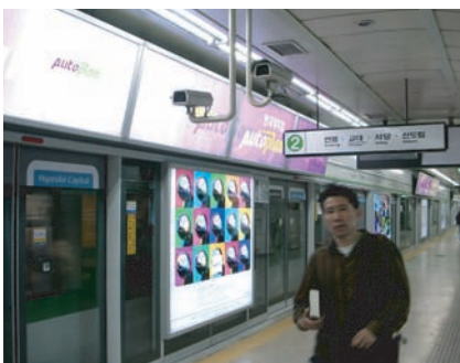
Parete di sicurezza della metropolitana
